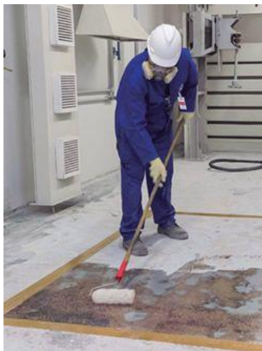
Imagem 12 – Aplicação de primer. Cichinelli (2015)
