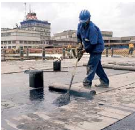
Imagem 5 – Aplicação da manta asfáltica
