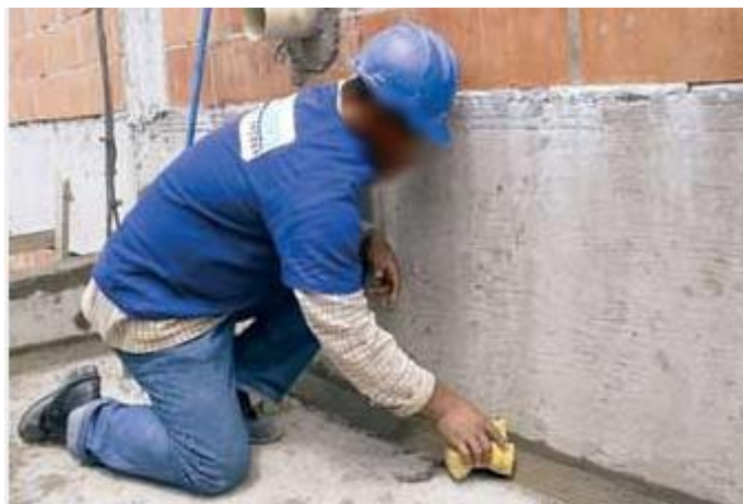
Imagem 2 – Preparação da superfície Pezzolo (2007)
