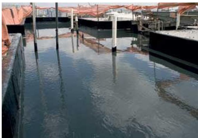
Imagem 9 – Teste de estanqueidade Pezzolo (2007)
