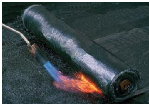
Imagem 6 – Aplicação da manta com maçarico Pezzolo (2007)
