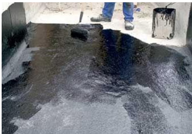
Imagem 4 - Aplicação do primer (Imprimação)
